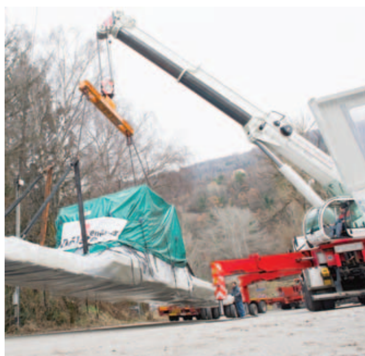
Une grue spéciale a été utilisée pour décharger la CNC de sa remorque. DASSELBORNE
